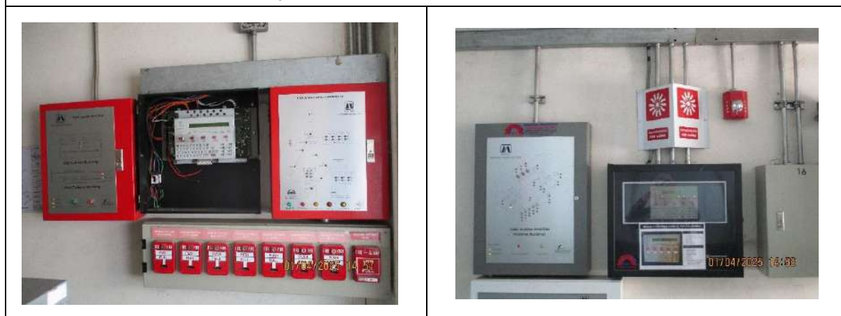
รูปที่ 2-24 ระบบสัญญาณเตือนภัย
